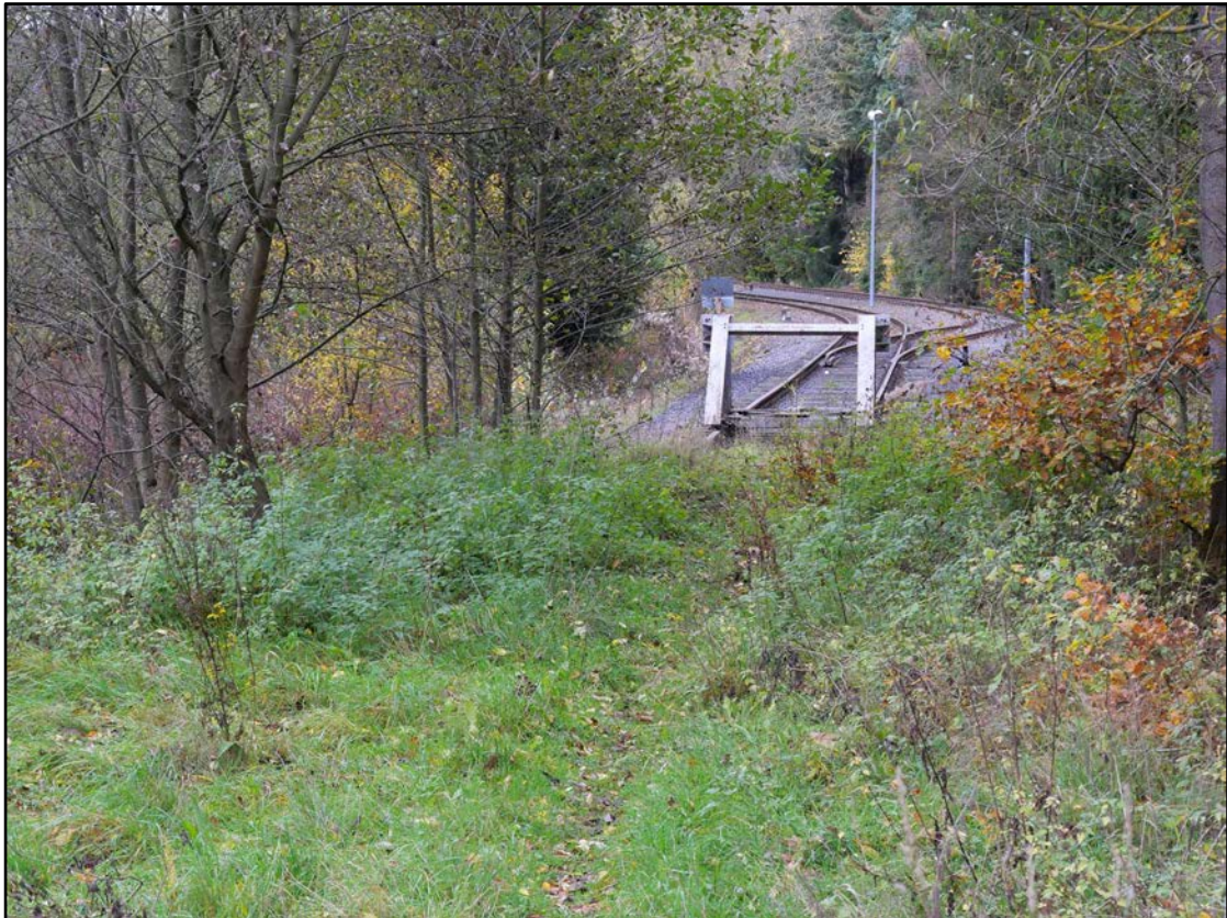
Abbildung 12: Gleisabschluss inkl. Pufferwerk der Kreisbahn Siegen-Wittgenstein GmbH Foto: Loth, Februar 2021
